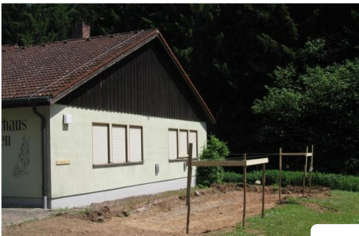
Das Schnurgerüst steht, die Arbeiten können beginnen.
