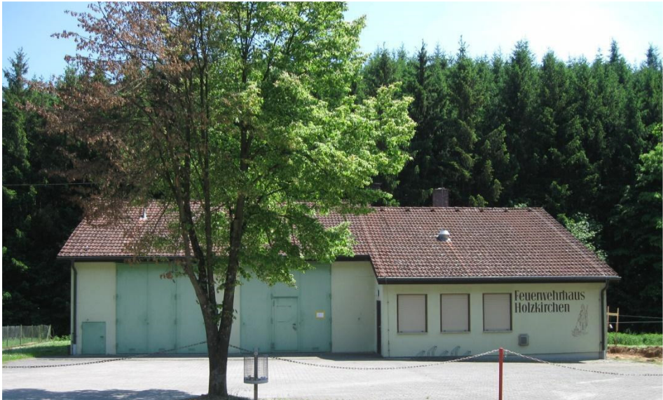
Das alte Feuerwehrhaus vor dem Umbau
